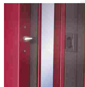
anti-crowbar device bolec antywyważeniowy
